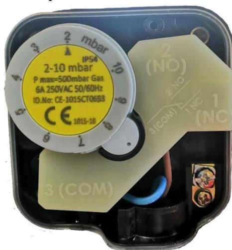
До начала работы горелки датчик находится в нормально разомкнутом положении. Как только запускается вентилятор, контакты реле замыкаются – датчик зафиксировал наличие перепада да-
