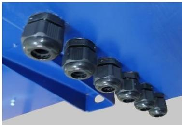
Через данные гермовводы подключить сигналы управления к разъемам ХТ12, ХТ14 блока расширения Т410.
